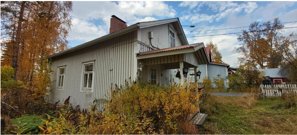
Kuva 102 rakennuksen julkisivua etelään ja itään pihan suuntiin sekä rakennuksen sisäänkäynnin katosta.
