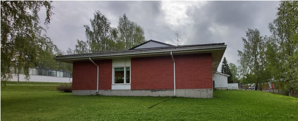
Kuva 29 Kirjaston päätyjulkisivu pohjoiseen pihan ja Haukivuoren torin suuntaan.
