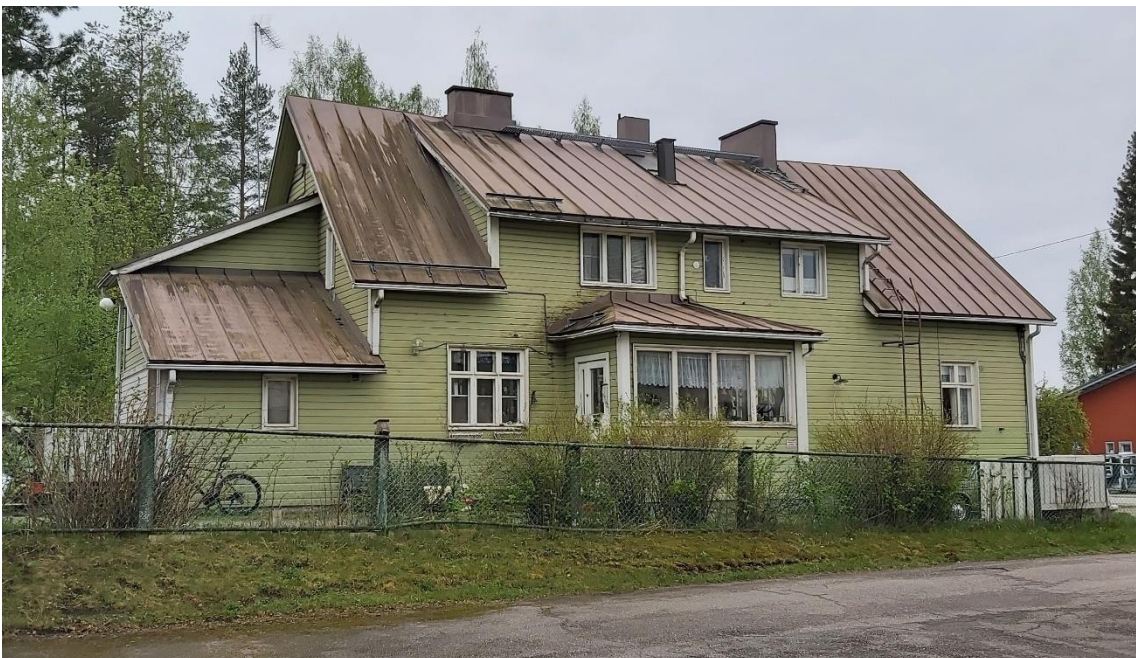
Kuva 82 Rakennuksen pohjoinen julkisivu, jossa sijaitsee rakennuksen pääsisäänkäynti.
