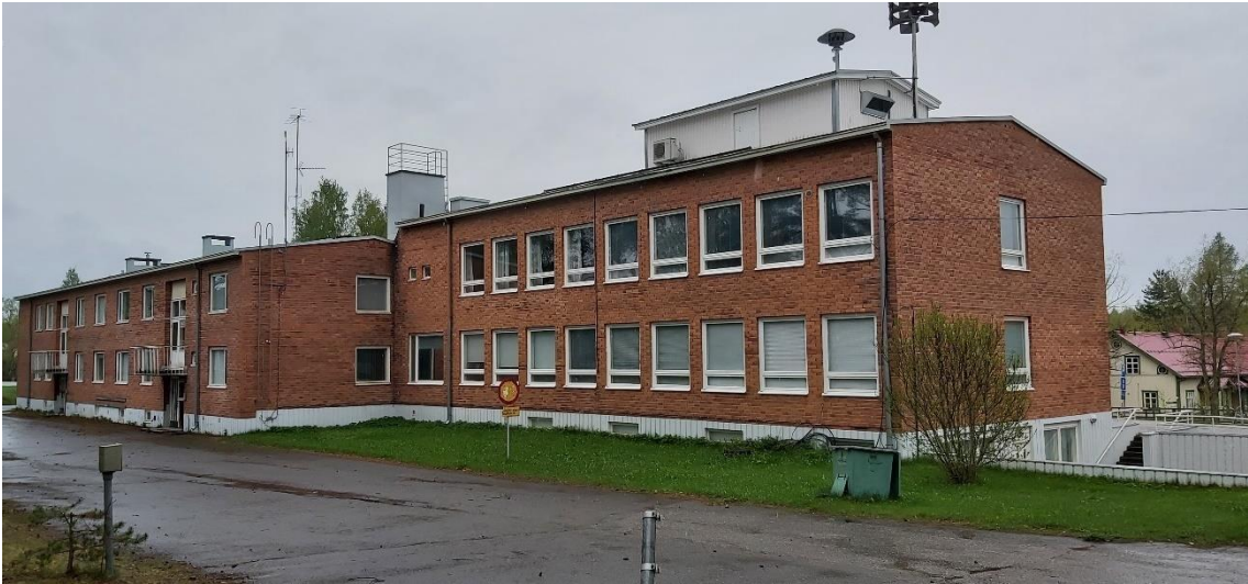
Kuva 37 Entisen kunnantalon julkisivua itään koulun suuntaan.
