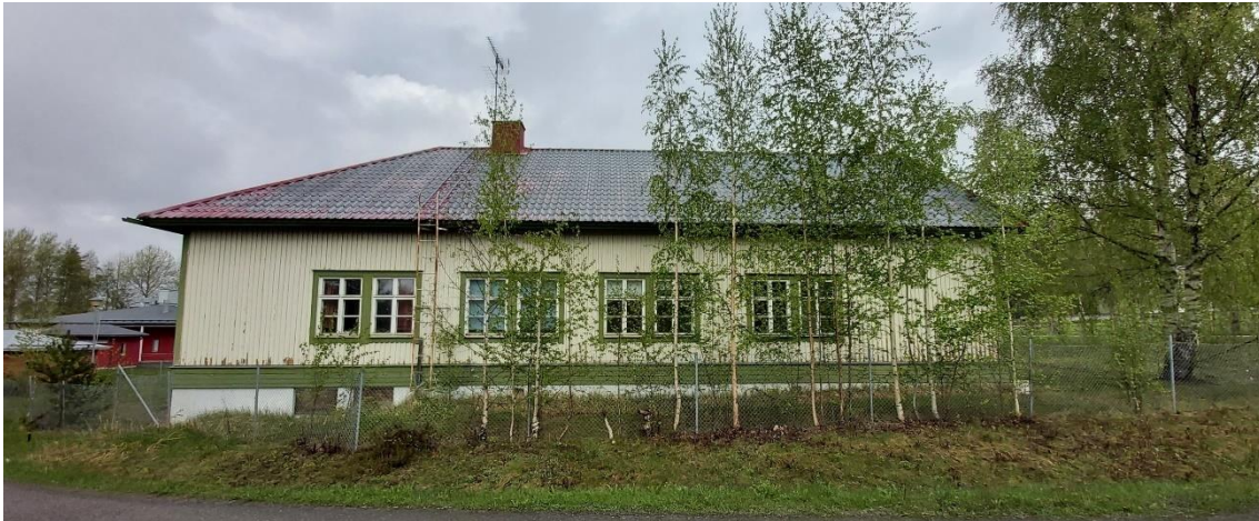
Kuva 33 Entisen kansakoulun ja nuorisotalon julkisivu etelään.
