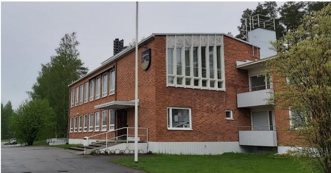
Kuva 36 Entisen kunnantalon pohjoisen osan eteläistä päätyä, jossa näyttävät salin ikkunat.
