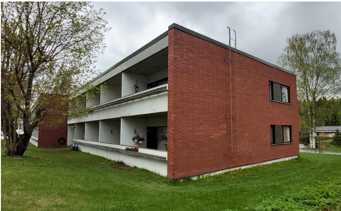
Kuva 89 Rakennuksen eteläinen pääty sekä länteen avautuvat nauhaparvekkeet.
