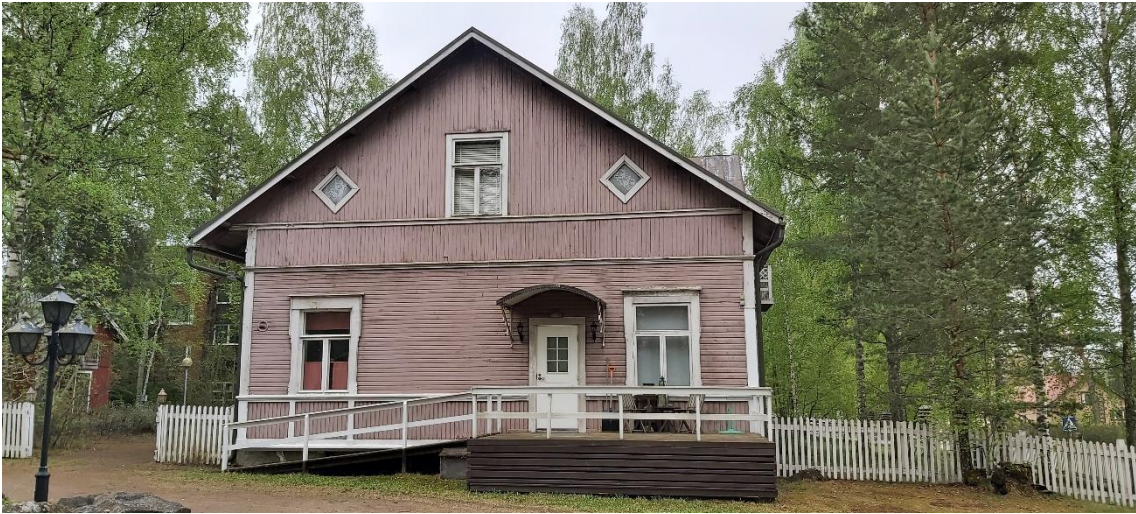
Kuva 15 Rakennuksen julkisivu pohjoiseen Haukivuoren torin suuntaan.
