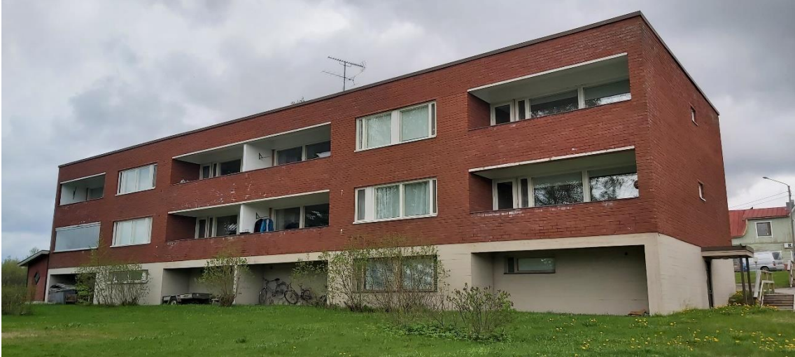
Kuva 91 Keskustien kerrostalon julkisivu länteen rakennuksen piha-alueen ja Pieksämäentien suuntaan sekä päätyjulkisivu etelään.
