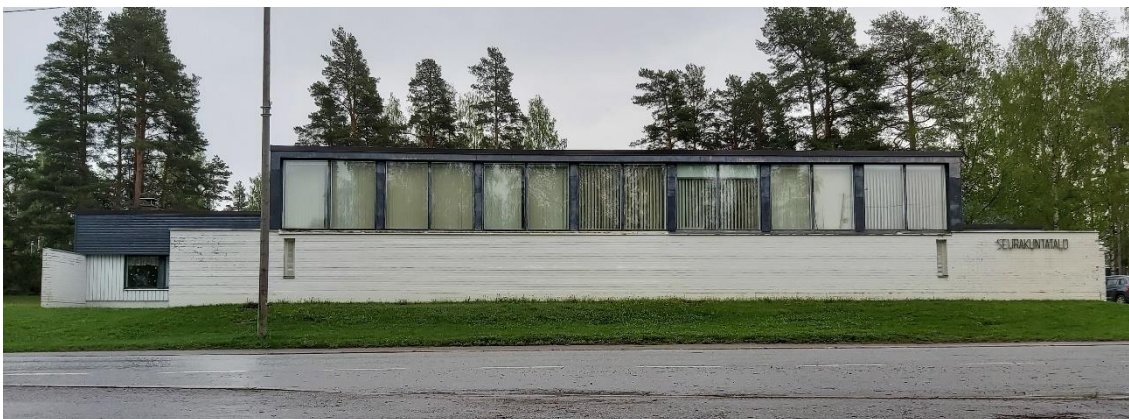
Kuva 23 Seurakuntatalon pääjulkisivu länteen Keskustien suuntaan.
