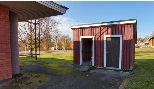
Kuva 50 Kiinteistöllä sijaitseva jätekatos.
