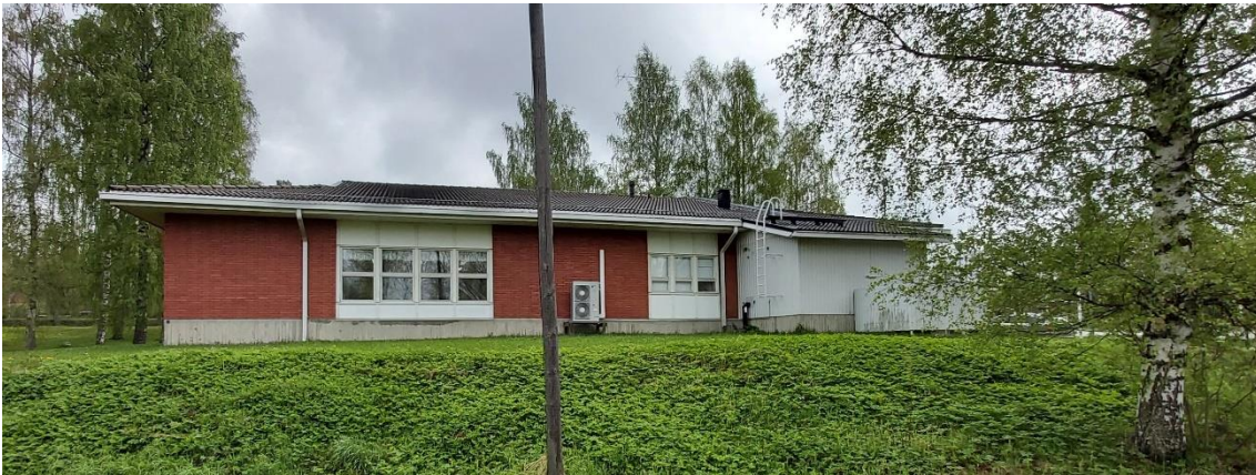
Kuva 30 Kirjaston julkisivu länteen avaraan lähimpäristöön.
