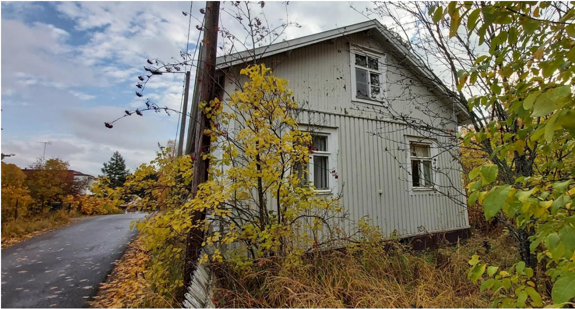
Kuva 101 Rakennuksen julkisivu länteen. Rakennus rajaa Suojatien kapeaa katutilaa.
