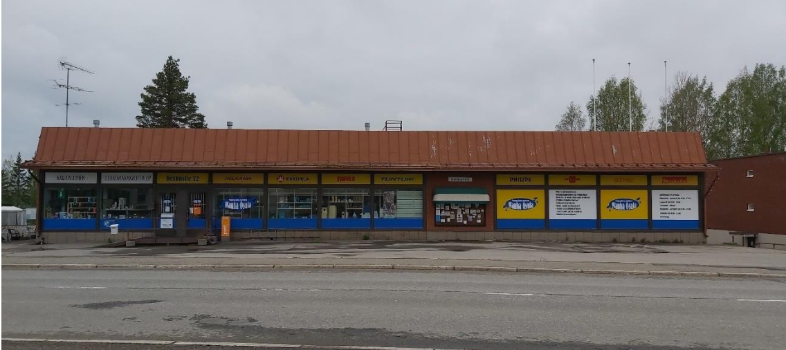
Kuva 61 Wanhan Osulan pääjulkisivu itään Keskustien suuntaan.
