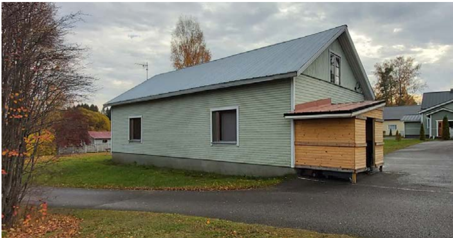
Kuva 58 Talousrakennuksen julkisivua pohjoiseen ja länteen.
