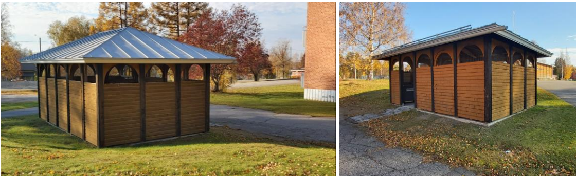
Kuva 40 Alueen piharakennuksena jätekatos, joka edustaa tyyliltään viereisen Hauki-Hallin piirteitä.
