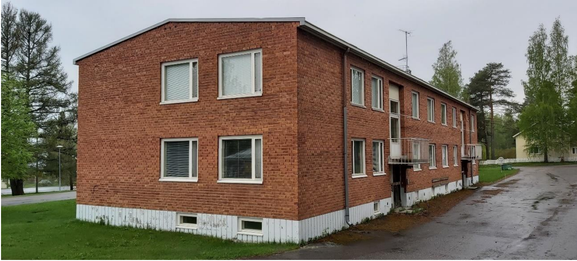
Kuva 39 Haukivuoren entisen kunnantalon eteläisen osan päätyjulkisivu etelään sekä julkisivua itään koulun suuntaan.
