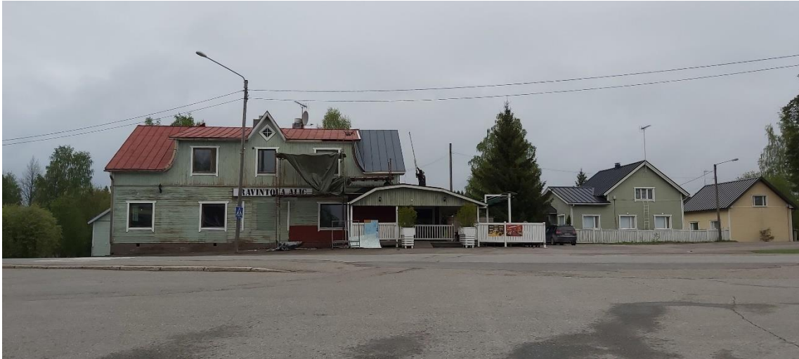
Kuva 53 Rakennuksen pääjulkisivu länteen Keskustien ja torin suuntaan suuntaan. Rakennuksen julkisivuja kunnostetaan parhaillaan kuvien ottamishetkellä 18.5.2021.
